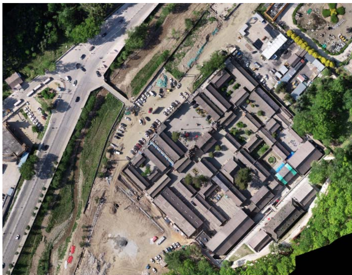
图 3 普化寺航拍影像图
