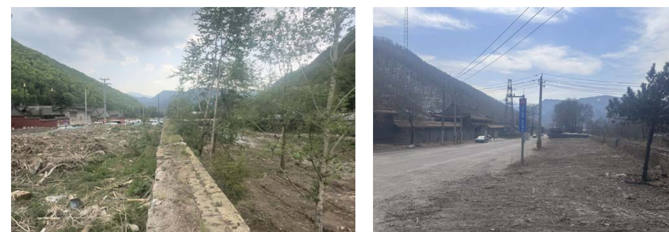
河堤顶部照片
