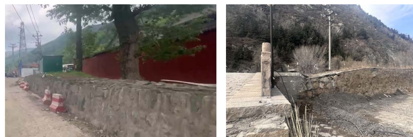
普化寺围墙外照片
