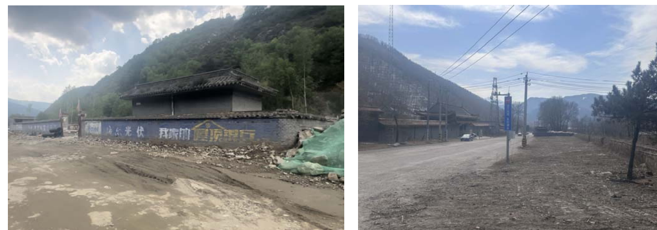
拟拆除污水站及路面照片
