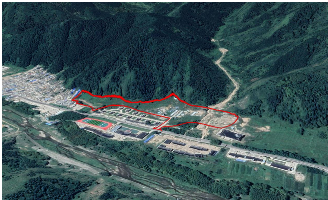
图 3.2 场地区域天然沟道照片
