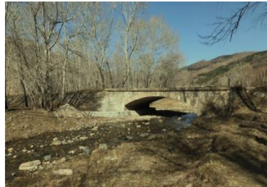
AK87+637 点桥梁现状图
