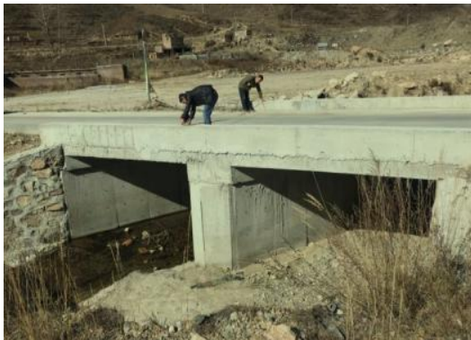
AK85+437 点桥梁现状图
